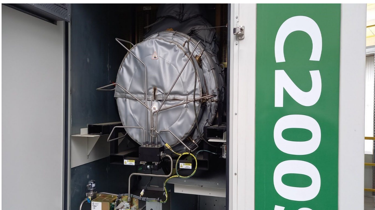
Mikroturbina – układ kogeneracji do produkcji energii elektrycznej i ciepłej
