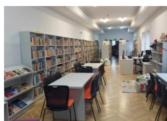
Remont biblioteki szkolnej
