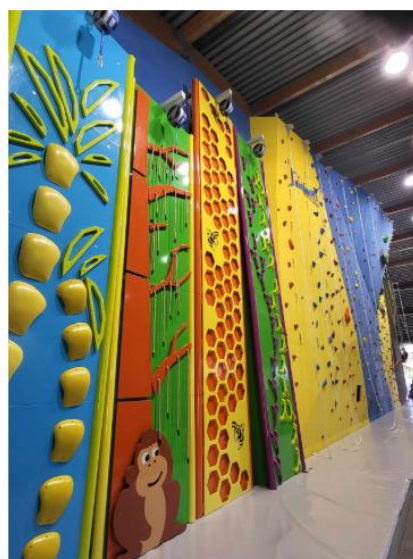
Dostawa i montaż ściany wspinaczkowej
