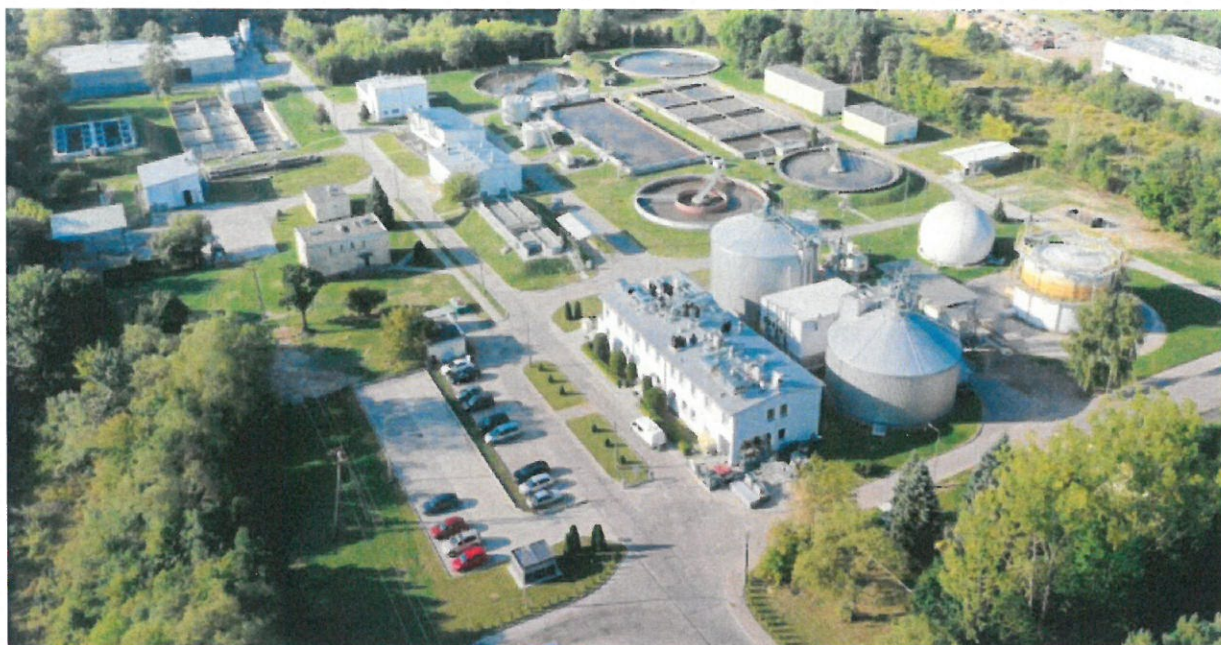
Oczyszczalnia ścieków w Mińsku Mazowieckim
