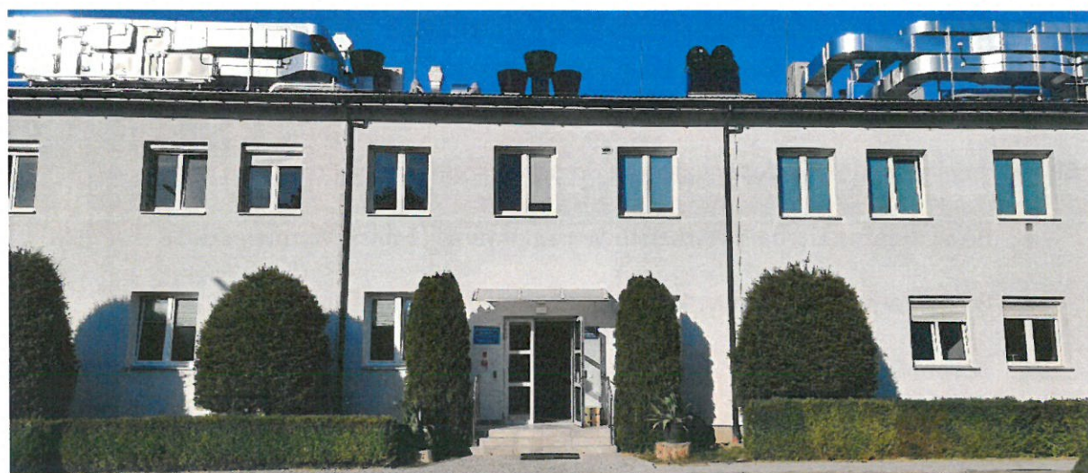
Budynek administracyjny wraz z laboratorium ob. nr 23
